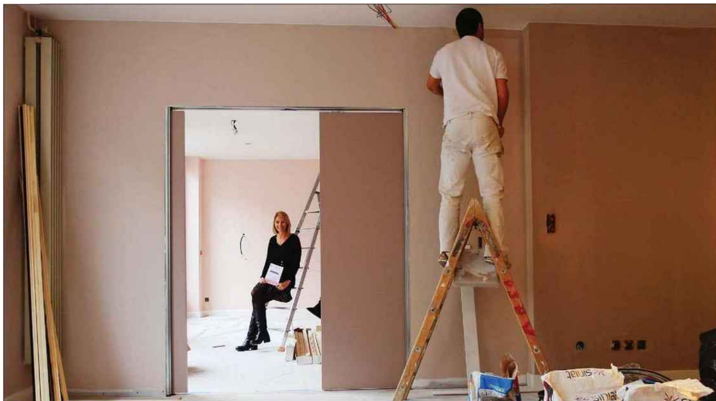
Céline Dupré, dans la Maison rose dont les travaux sont en cours de bouclage. Ouverture prévue le 1 er février. PHOTO: GUILLAUME BONNAUD
